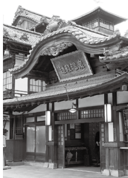
道後温泉の顔・道後温泉本館。 明治27年建造の三層楼の建物は国重要文化財。
